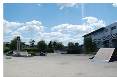
スケートパーク川西 （愛知県小牧市） 面積 2,000 m 2 市直営管理（使用料：無料）
