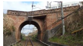
伊賀鉄道桑町跨線橋
