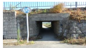
伊賀鉄道小田第二暗渠
