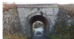
伊賀鉄道小田拱橋
