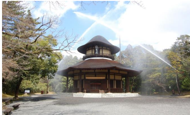
俳聖殿での一斉放水状況
