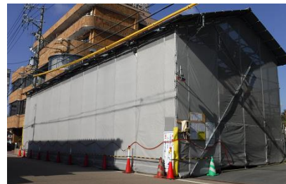
平成30年度 工事着手後
