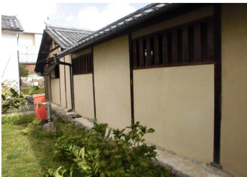
北控所や渡廊下の土壁修理後
