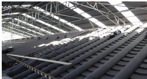
令和元年度 工事中
