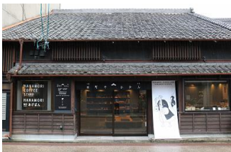
外部の様子(新規テナントの出店)
