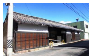
有形文化財(建造物)成瀬平馬家長屋門
