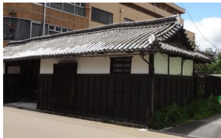
平成29年度 工事着手前
