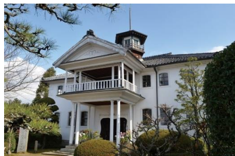
旧小田小学校本館（小田町・県指定）
