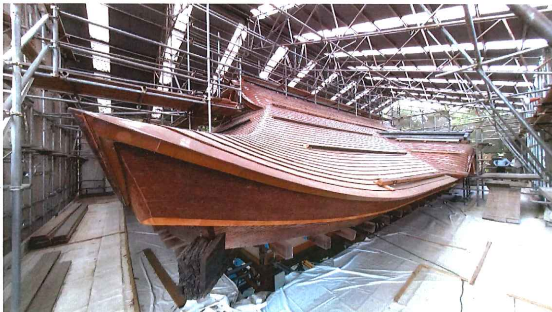
銅板葺き・棟瓦復旧
