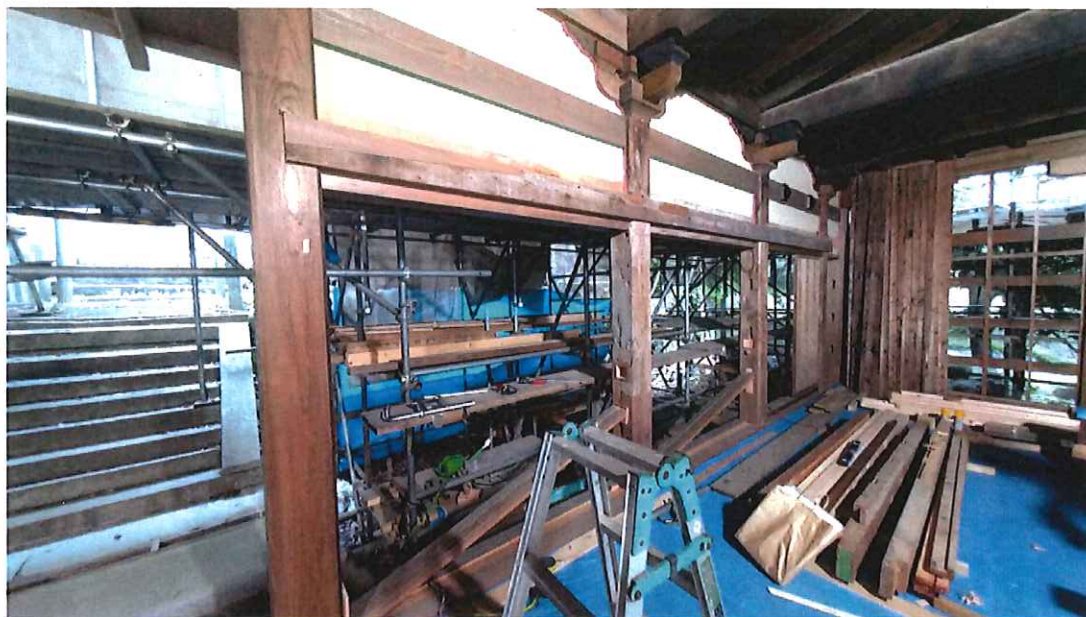
拝殿内部の土壁や板壁の復旧作業 （今後の作業）
