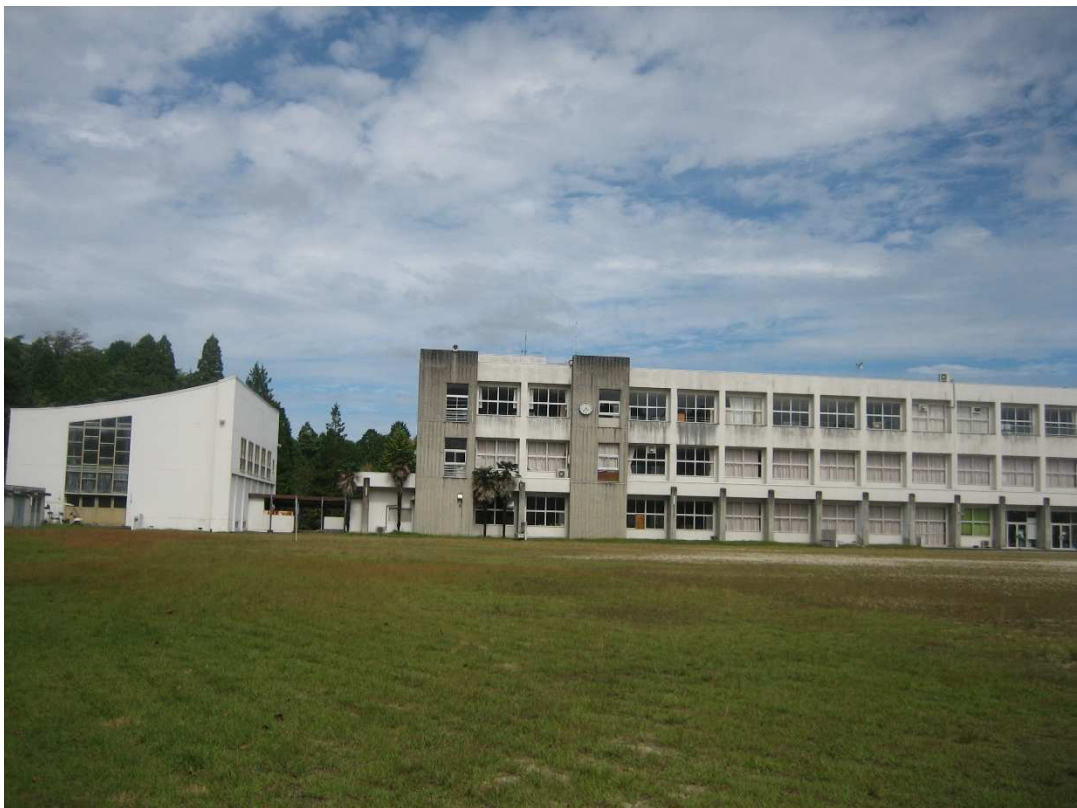
校舎・体育館（正面）
