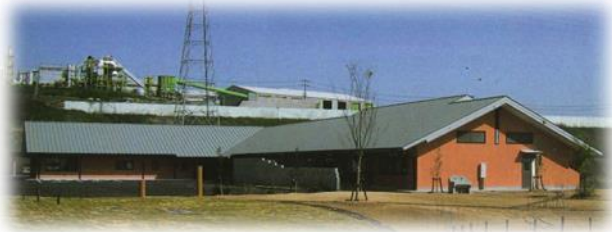
伊賀市環境センター
