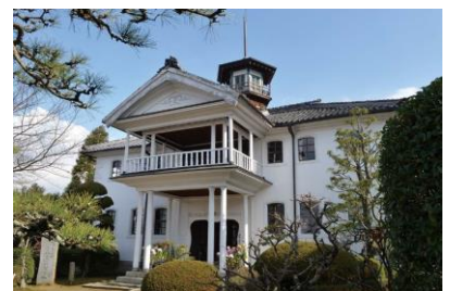
旧小田小学校本館(小田町・県指定)
