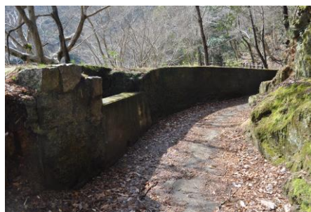
巖倉水力発電所の水路跡
