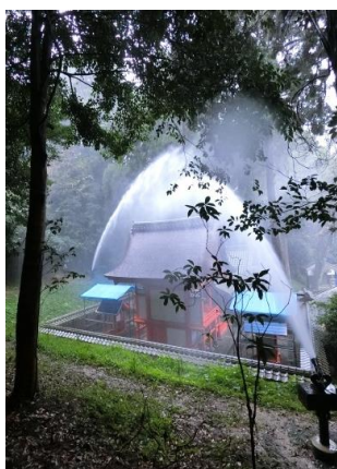
完成した重文猪田神社の 防災設備試験放水
