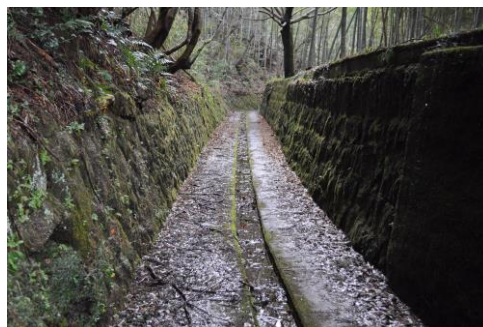
巖倉水力発電所の水路跡
