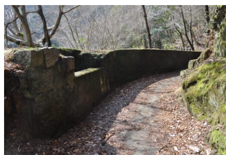
巖倉水力発電所の水路跡(西山)
