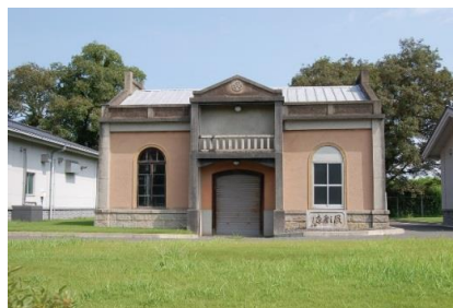
上野市上水道水源地送水機関室 （小田町・国登録）
