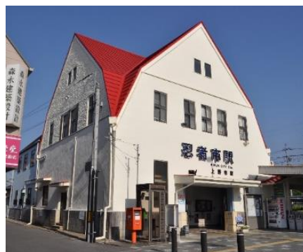
伊賀鉄道上野市駅舎
