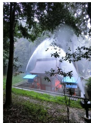
完成した重文猪田神社の 防災設備試験放水
