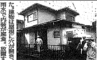
略式代執行による解体が始まった空き家（伊賀市）
