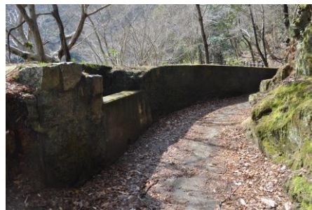
巖倉水力発電所の水路跡(西山)
