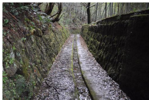
巖倉水力発電所の水路跡
