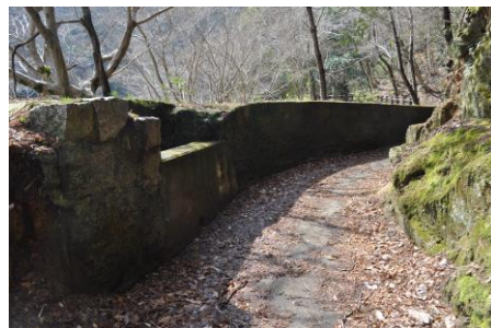
巖倉水力発電所の水路跡（西山）
