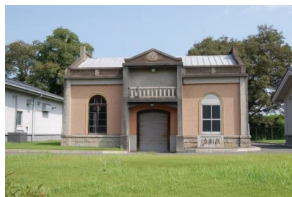
上野市上水道水源を送水機関室 （小田町・国登録）
