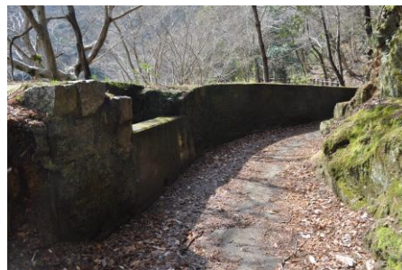
巖倉水力発電所の水路跡(西山)
