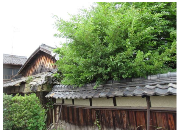
樹木繁茂状況
