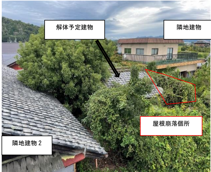
敷地内の樹木が隣地建物に覆いかぶさっていた
