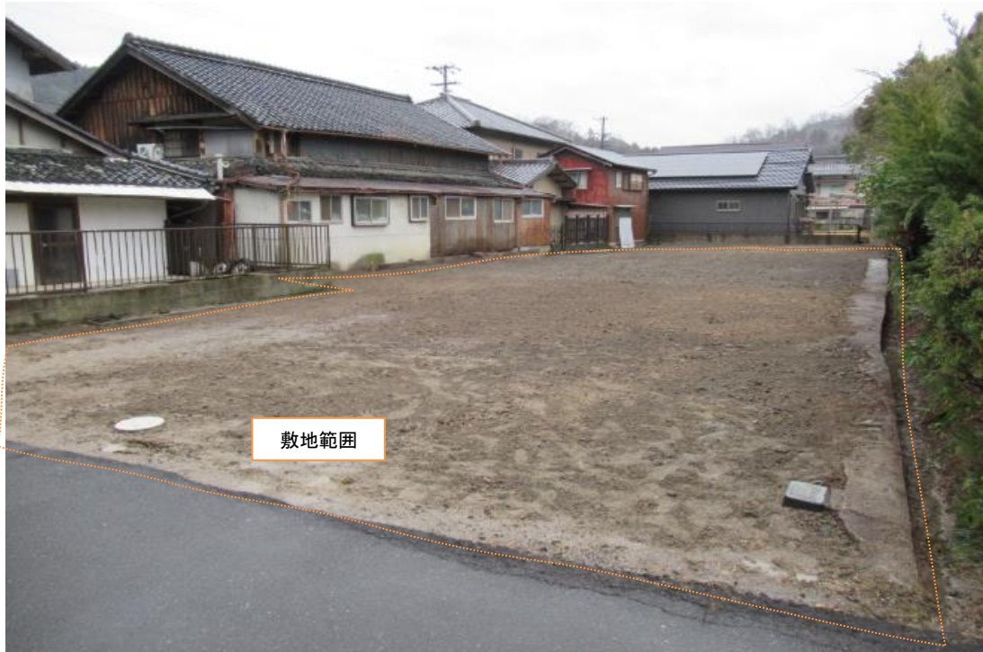
敷地内建築物等の除却完了状況 R6.2.5 撮影
