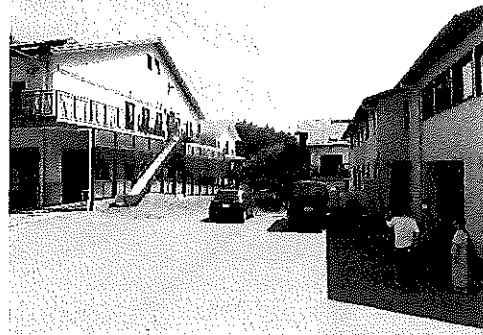
※写真右は事務所棟、左及び奥は入居者棟
