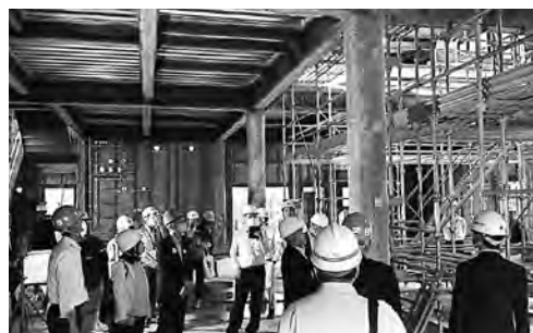
忍者体験施設1階工事現場の現地調査
