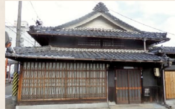
▲漆喰壁や格子窓、格子が上野城下町の景観を伝える(西から)
