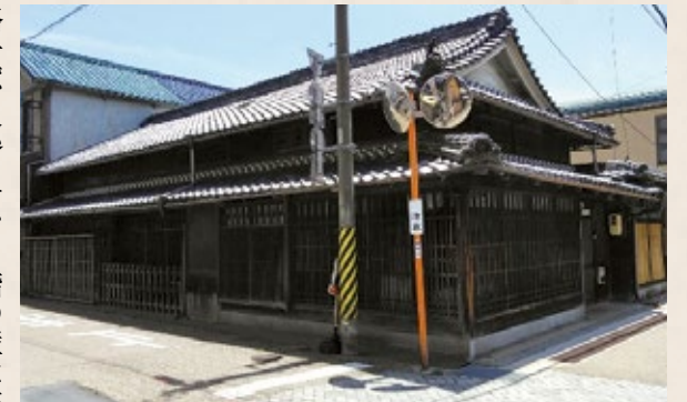
▲星家住宅主屋は北側と西側が通りに面する(北西から)
