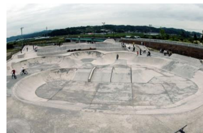
中津川公園スケートパーク （岐阜県中津川市）
