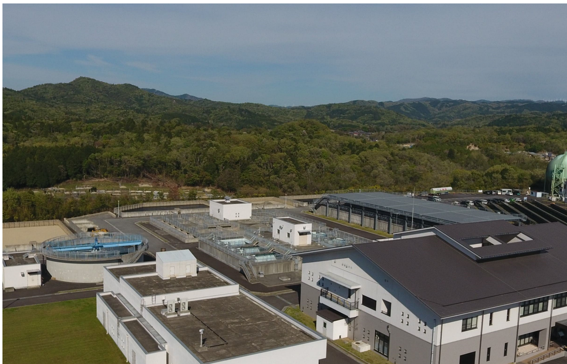
ゆめが丘浄水場
