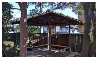
蓑虫庵 月見堂 屋根葺き替え工事
