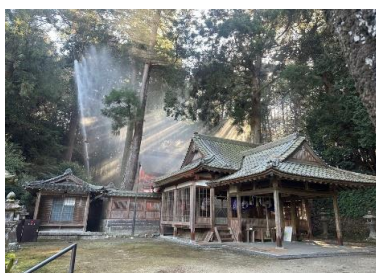
防災設備点検 猪田神社（猪田）
