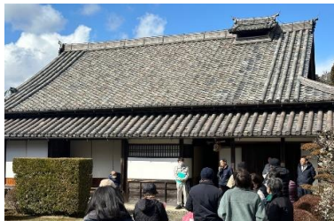
町井家住宅主屋及び書院 保存修理現地説明会
