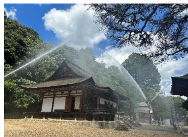
防災設備点検 観菩提寺本堂・楼門
