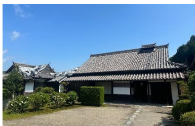
町井家住宅主屋及び書院保存修理
