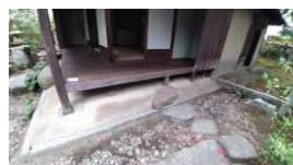
菰虫庵土間漆喰(施工前)
