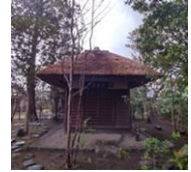
芭蕉堂葺き替え・部分修理
