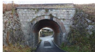
伊賀鉄道小田拱橋
