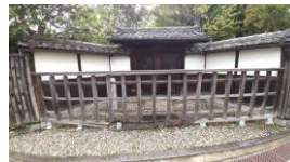
正門車止め(施工前)
