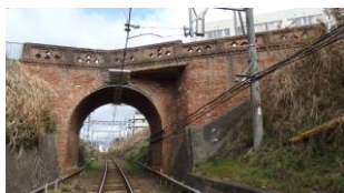
伊賀鉄道桑町跨線橋
