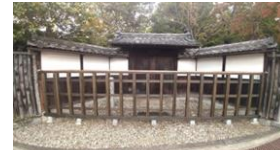
正門車止め(施工後)
