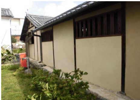
北控所や渡廊下の土壁修理後
