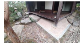
菰虫庵土間漆喰(施工後)
