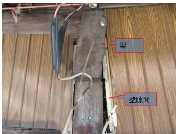
敷地西面 建物状況
