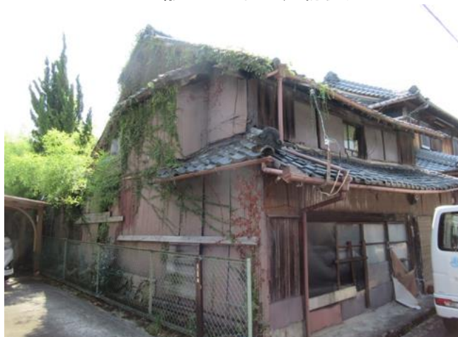
敷地北西面 建物状況
