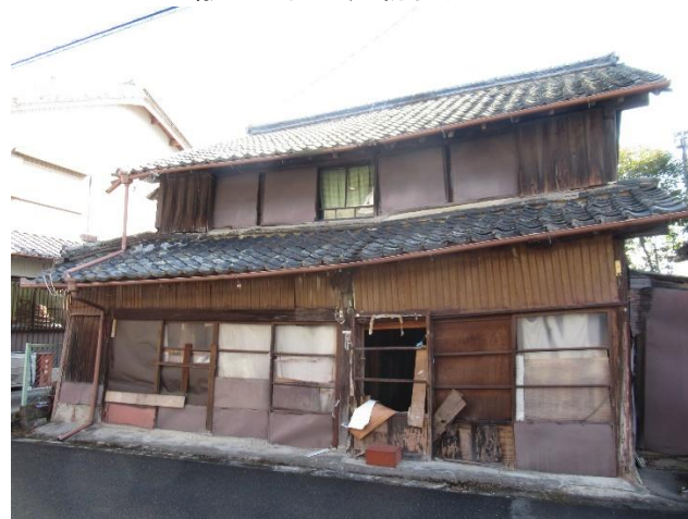
敷地西面 建物状況
