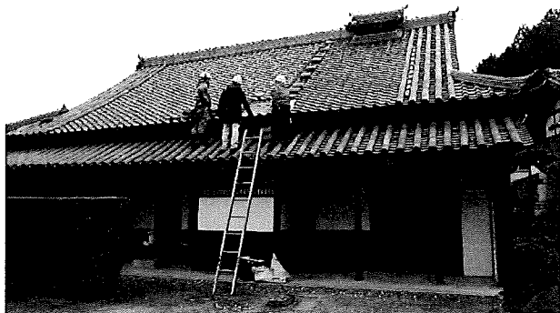
・重文 町井家住宅主屋・書院 保存修理事業（国補助）
