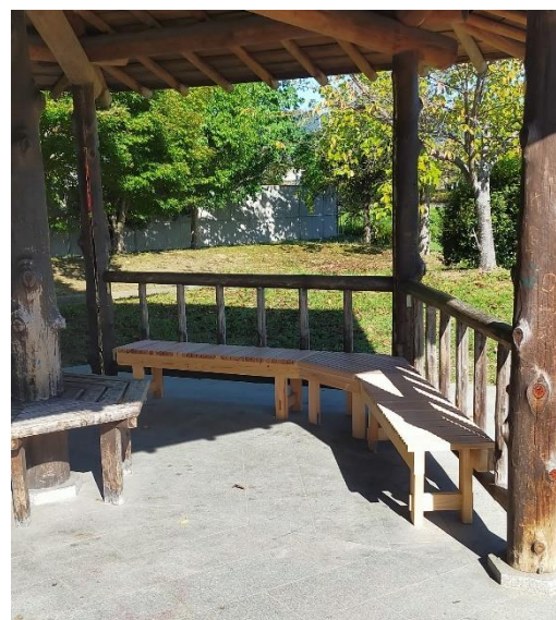
【参考】8月、9月に破壊されたベンチの復旧状況
