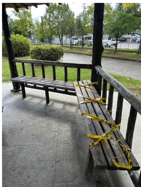
破壊ベンチの保全状況
