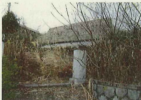
敷地全体の樹木の繁茂 敷地外への樹木の繁茂
