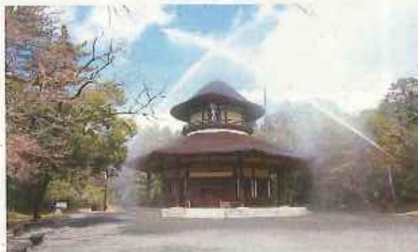
排聖殿での一斉放水状況
