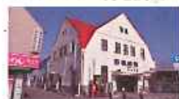
伊賀鉄道上野市駅舎
