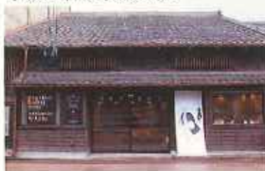
外観の様子(新規テナントの出店)
