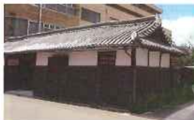
平成29年度 工事着手前
