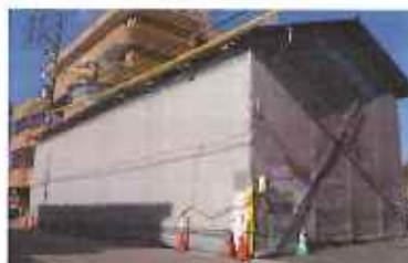
平成30年度 工事着手後
