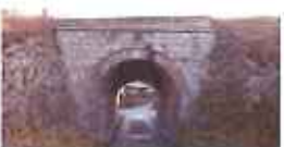
伊賀鉄道小田拱橋
