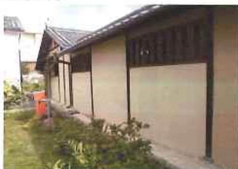
北控所や渡廊下の土壁修理後
