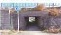
伊賀鉄道小田第二暗渠
