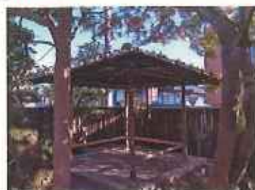
月見堂の屋根葺き替え、補修等実施
