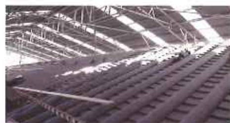
令和元年度 工事中
