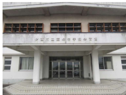
外壁塗装改修
