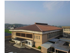
銅板屋根防水改修
