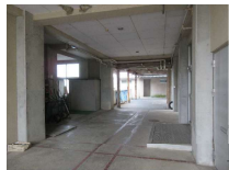
校舎棟・技術室間へのスロープ設置
