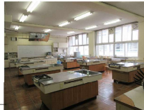
調理室への空調設置
