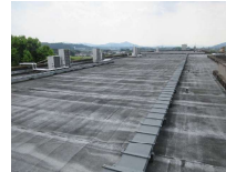
屋上防水改修
