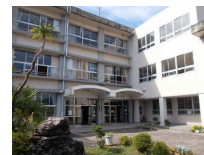
外壁塗装改修
