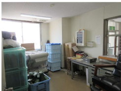
多目的トイレ設置 （照明操作盤・火災受信機移設とも）
