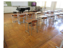
音楽室内へスロープ設置
