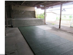
校舎棟からの階段横へスロープ設置
