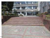
アプローチ階段横へスロープ設置
