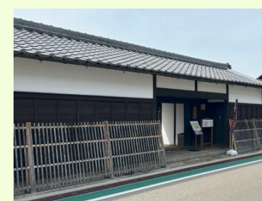
6. 赤井家住宅主屋（上野忍町）
