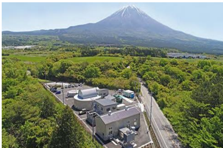
図 富士開拓農協のバイオガスプラント(21軒の零細農家がふん尿(合計350頭分)を提供し、発電)
