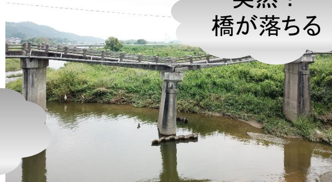
架橋後、65年が経過し落橋した橋梁
