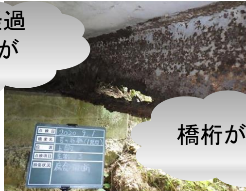
鋼桁の腐食・破断(60年経過)
