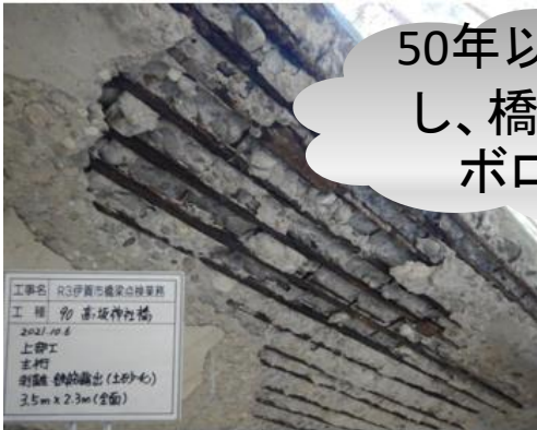
鉄筋コンクリート桁の劣化(60年経過)
