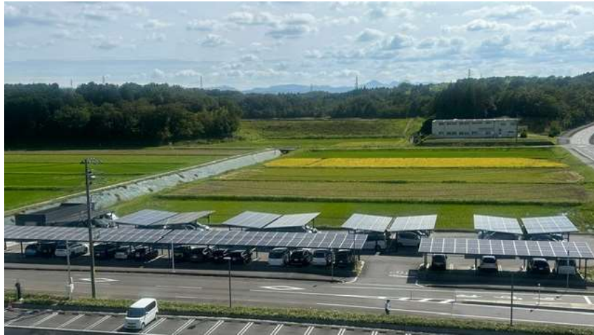
図12 伊賀市役所本庁舎駐車場における太陽光発電システムの設置 (出典：本市撮影)
