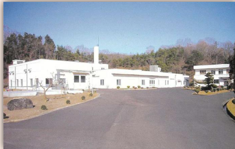
伊賀南部浄化センター全景
