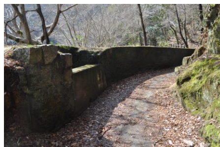
巖倉水力発電所の水路跡（西山）
