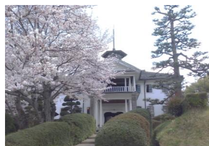
旧小田小学校本館
