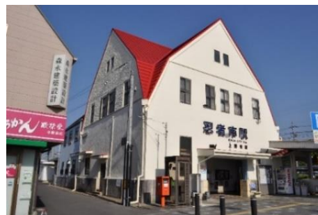
伊賀鉄道上野市駅舎
