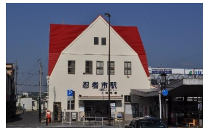
伊賀鉄道上野市駅舎
