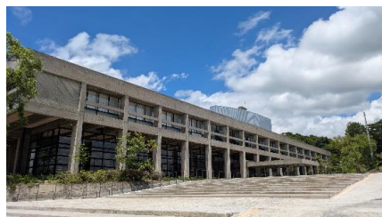
改修を終え一部開業した旧上野市庁舎
