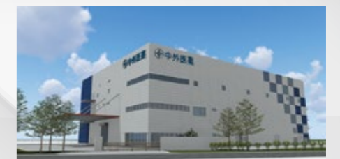
みどりヶ丘第三工場(2026年12月完成予定)
