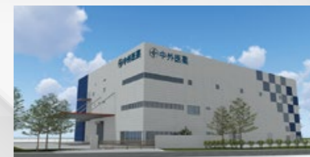
みどりヶ丘第三工場 (2026年12月完成予定)
