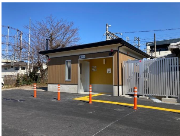
駅の多目的トイレの整備（茅町駅）
