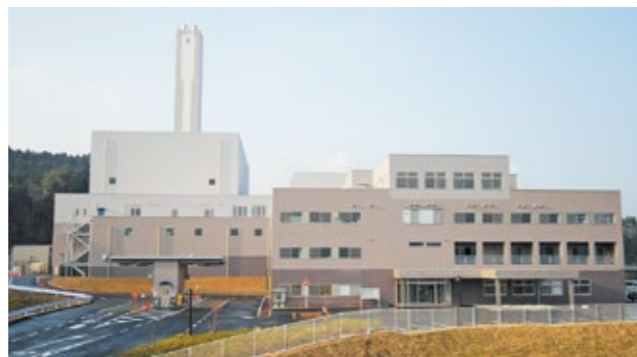
伊賀南部クリーンセンター（奥鹿野）
