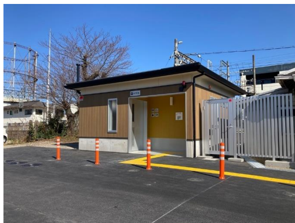
駅の多目的トイレの整備（茅町駅）
