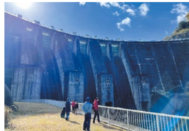
▲高山ダム堤内探検ツアー
