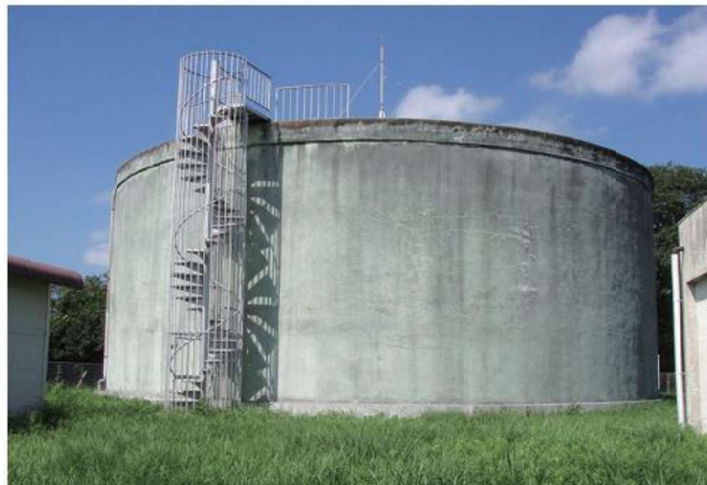
伊賀第1配水池
