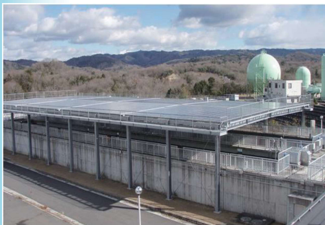
ゆめが丘浄水場
