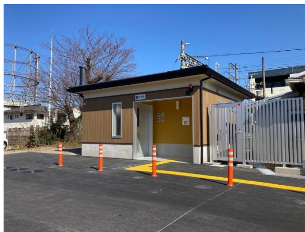
駅の多目的トイレの整備（茅町駅）
